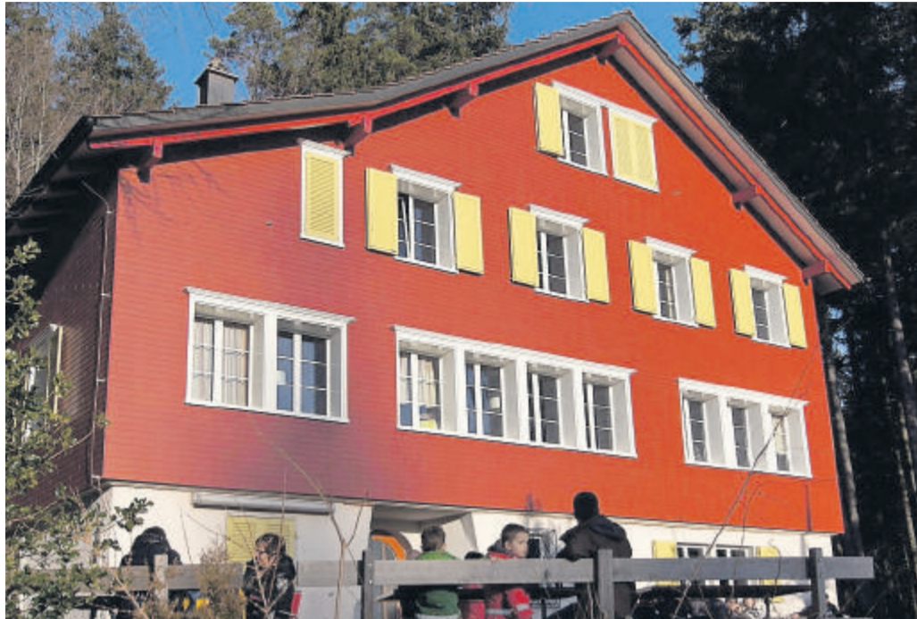
Im neuen Gewand: Die Fassade strahlt in frischem Rot und auch die Fenster wurden erneuert.
