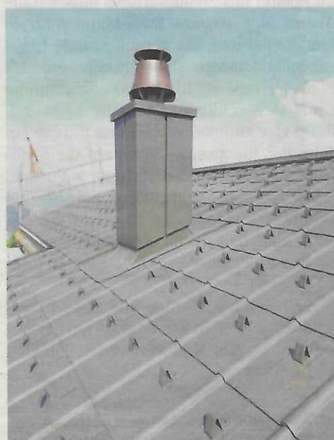
Schön ist es geworden, das neue Dach.
