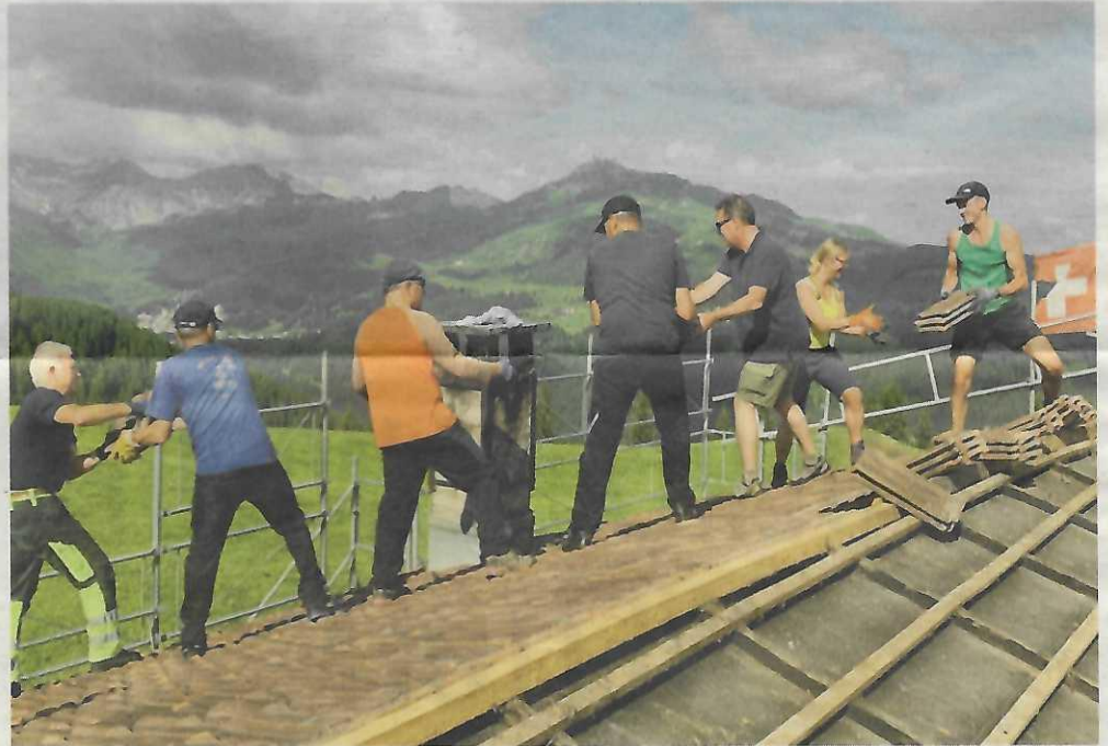
Zuerst musste das alte Dach abgedeckt werden.
