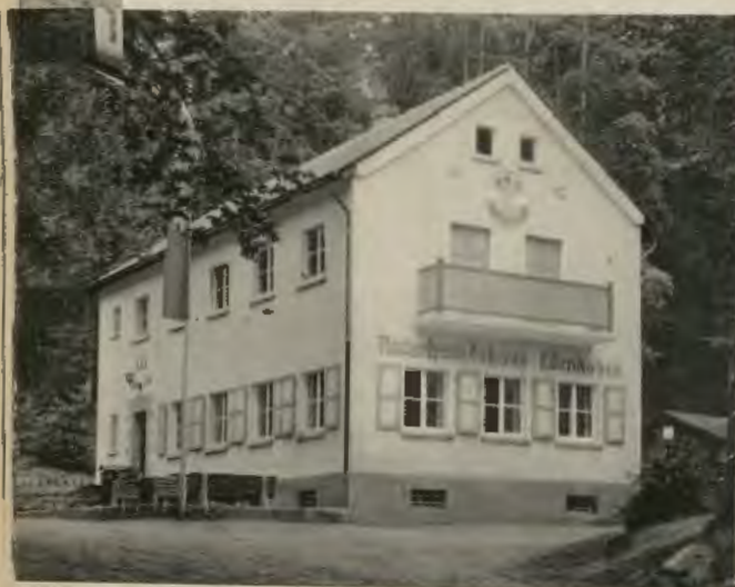
Haus der OG Edenkoben (Rheinpfalz)
