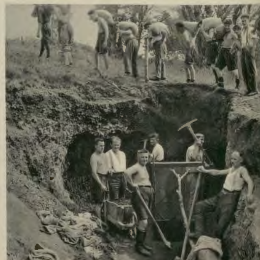
Beim Bau des Thanner Naturfreundehauses auf dem Molkenrain, am 16. Juni 1930. Grund ausheben und wegtransportieren
