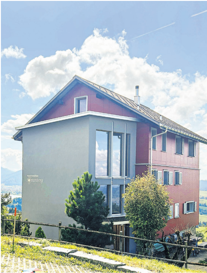
Durch die umfassende Sanierung im Jahr 2010 erhielt das Naturfreundehaus mit dem Anbau seine heutige Form. Foto: as
